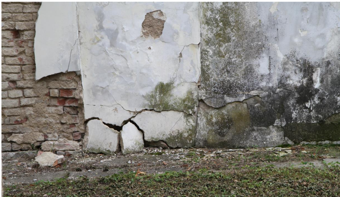
Silně poškozené omítky terasy na západním průčelí-detail
