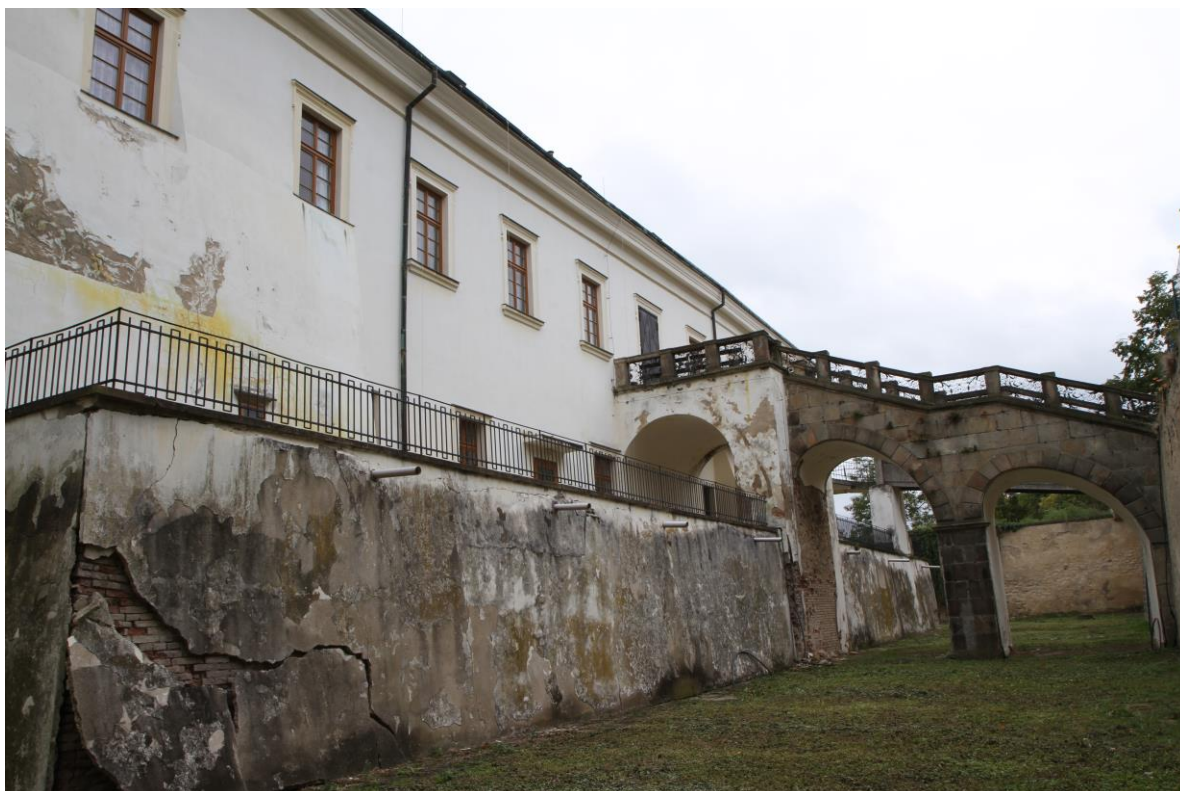
Silně poškozené omítky terasy na západním průčelí
